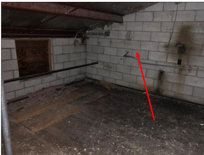
CMU & CMU Mortar
